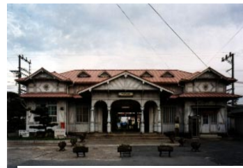
旧南海本線浜寺公園前駅
